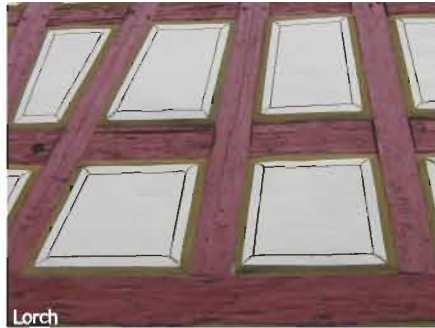
Fachwerk mit durch farbige Linien abgesetzten Ausfachungen
