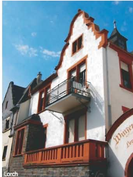
Die Ausführung der Balkone folgt der Gliederung des Gebäudes: Massiv über dem Sockelgeschoss, filigran im verputzten Obergeschoss
