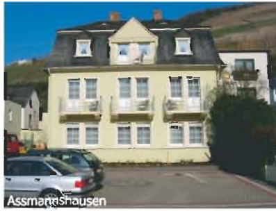
Die Balkone ordnen sich in Gestalt und Symmetrie der Fassade unter und dominieren sie nicht
