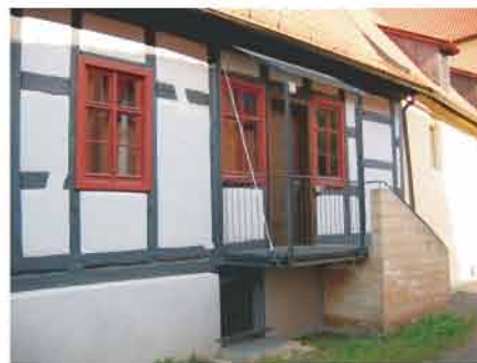
Vorbildlich: Ein dezent angefügter moderner Vorbau für den erhöht liegenden Eingang vermeidet durch seine Leichtigkeit und Materialität eine Konkurrenz zur historischen Fassade
