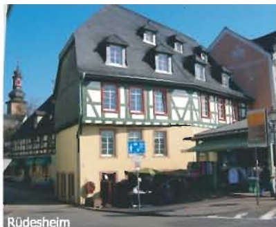
Große Dachfläche mit untergeordneten Sattelgauben
