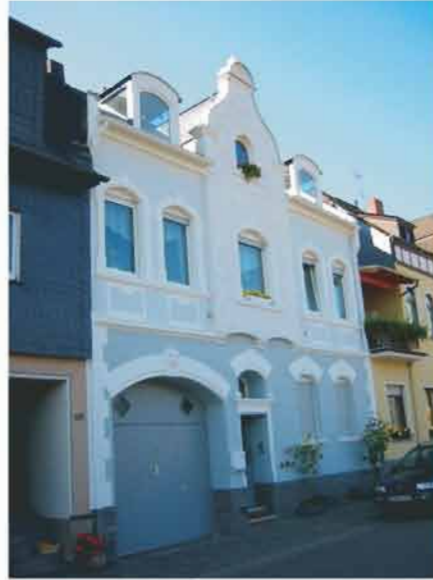
Belichtung des Dachgeschosses durch untergeordnete verglaste Gauben
