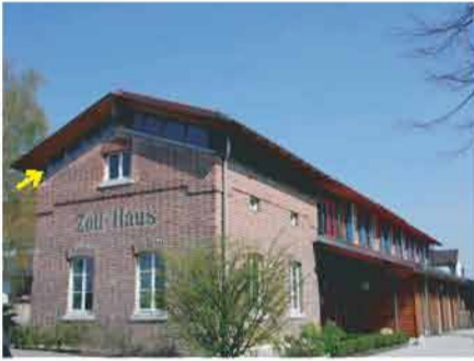
Gelungener Dachausbau: Eine „Glasfuge“ zwischen ursprünglicher Wandfläche und Dach ermöglicht die Beibehaltung von Dachform und -neigung und belässt die ursprüngliche Substanz ablesbar
