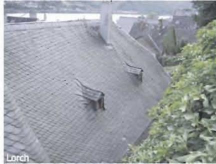
Typisch: Steile Satteldächer und ruhige Dachflächen
