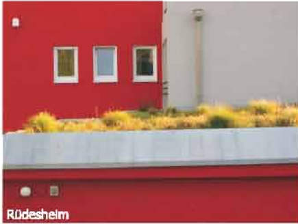
Eine extensive Dachbegrünung auf dem Garagenanbau bereichert das Wohnumfeld in optischer wie ökologischer Hinsicht
