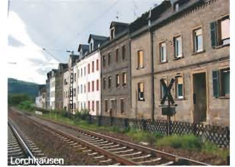
Lorchausen Als reine Wohnhäuser errichtet wurden diese Gebäude an der Bahnlinie
