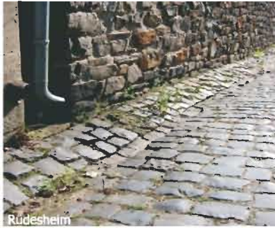
Elne Im selben Material wie die Gasse gepflasterte Rinne dient der Ableitung des Regenwassers
