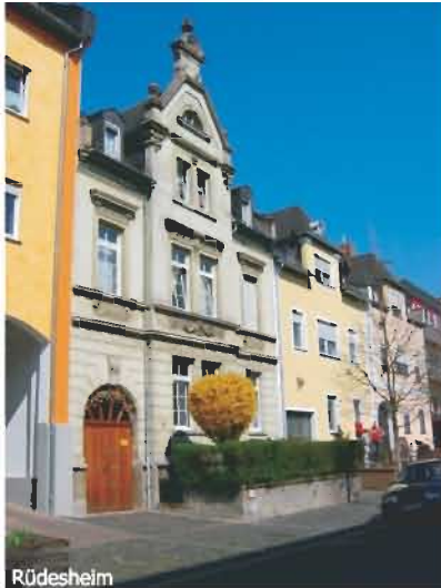
Rüdesheim Gründerzeitliches Wohnhaus in der geschlossenen Bebauung
