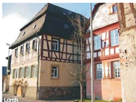
Charakteristisch für den frühen Barock: Teilweise überputztes Fachwerk, symmetrische Fassade und Mansarddach
