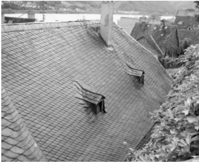
Dunkelfarbige Dacheindeckungen aus überwiegend Schiefer prägen die Dachlandschaft von Lorch.
